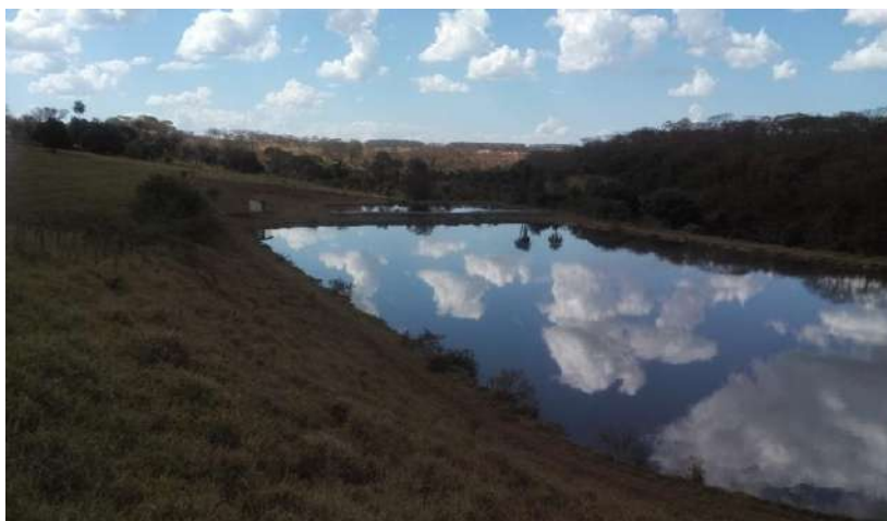
Foto 3.24 – Vista da lagoa facultativa
