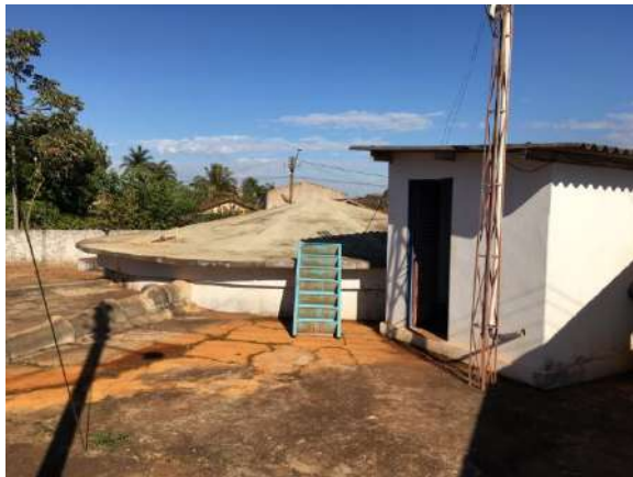
Foto 3.15 – EEAT-1 – Vista do EEAT e do reservatório de contato
