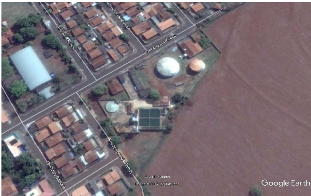
Foto 3.6 – Vista Aérea da ETA São José da Bela Vista e do Centro de Reservação (Fonte: Google Earth)
