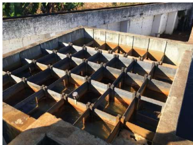
Foto 3.8 – Detalhe dos flocladores em chicanas de madeira
