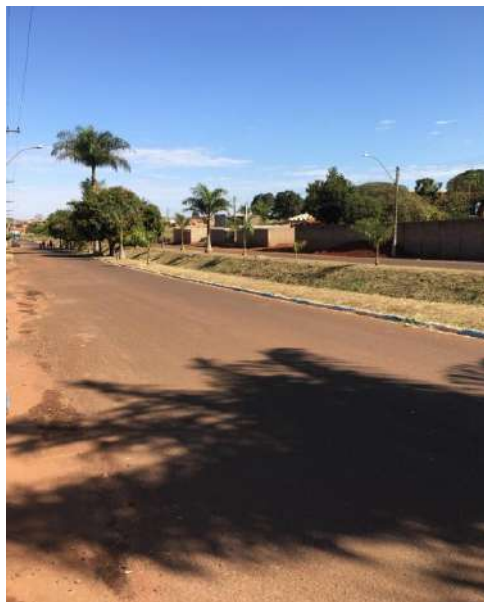
Foto 3.27 – Vista do trecho de sarjetas junto ao canal da Rua Luís Gonzaga Simei
