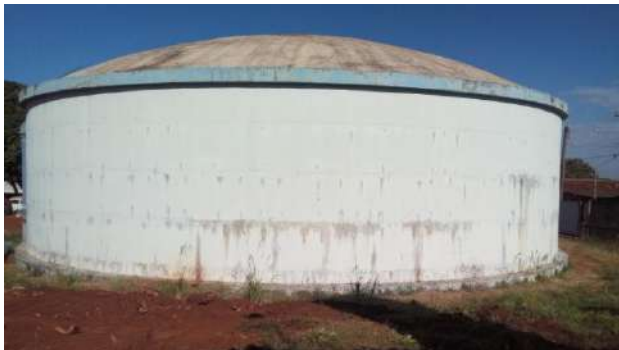
Foto 3.13 – Vista do reservatório apoiado de concreto no Centro de Reservação da ETA
