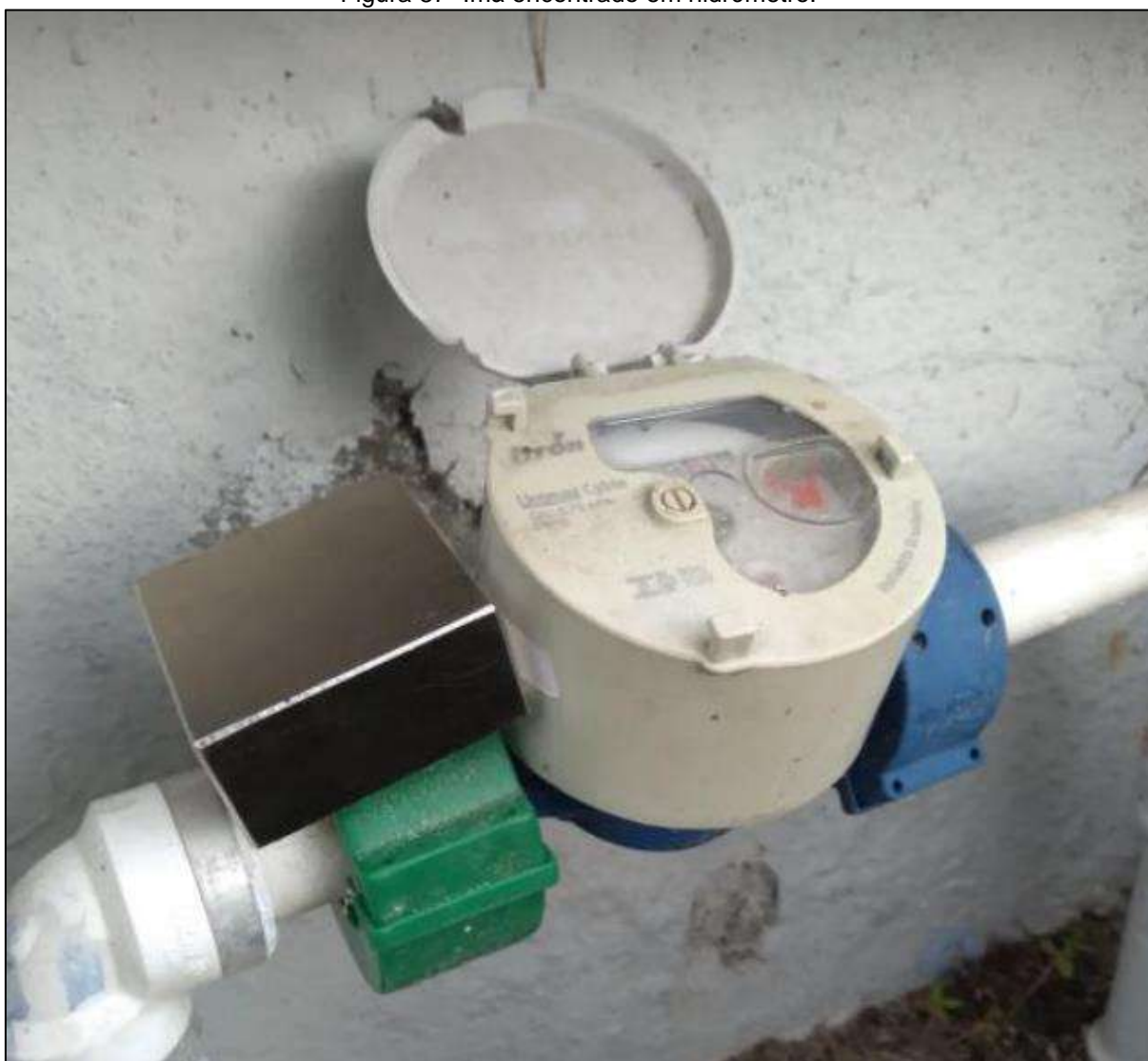
Figura 87 -Ímã encontrado em hidrômetro.
