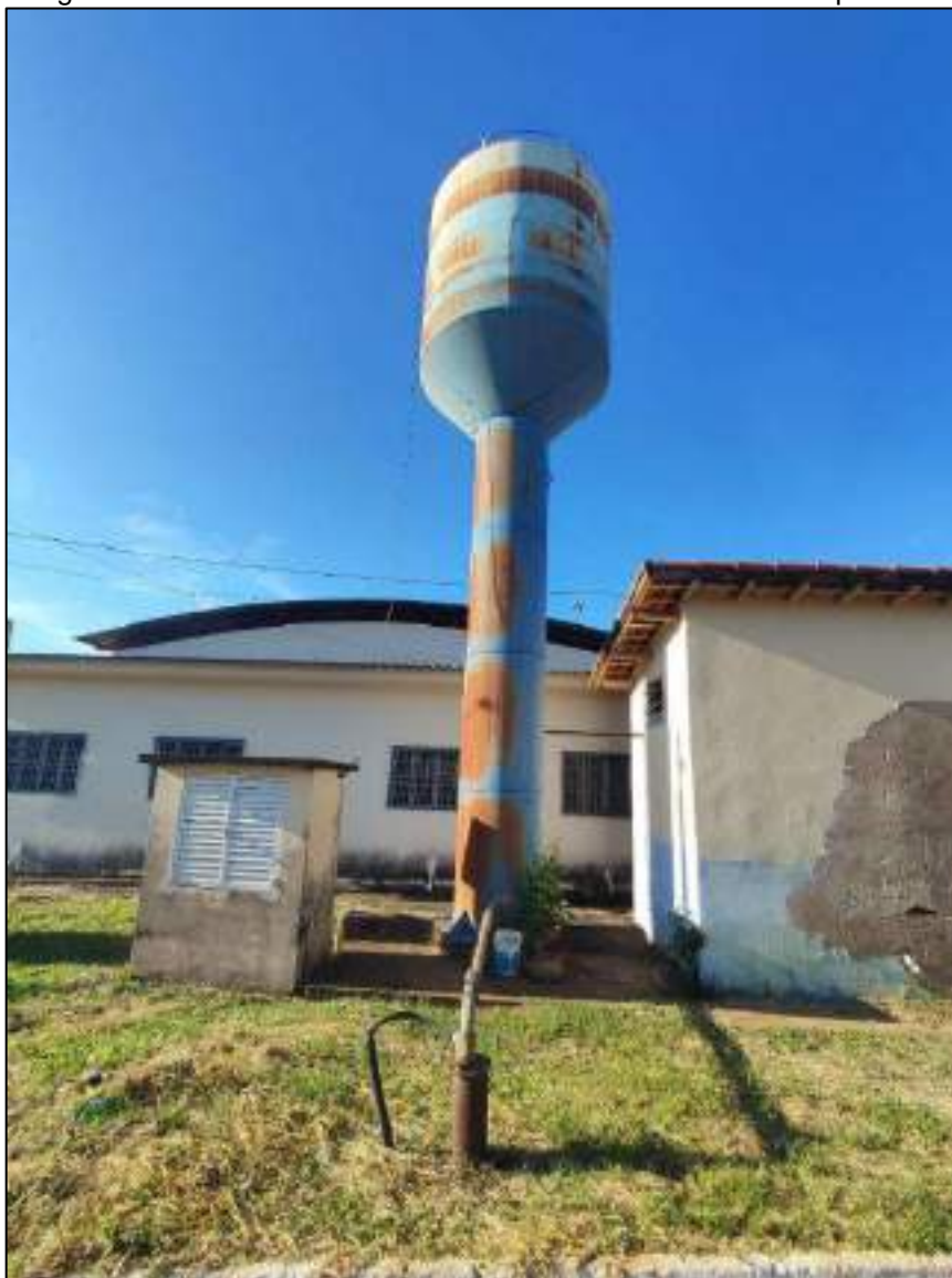
Figura 11: Reservatório elevado Buritizinho 25 m 3 e casa de química.
