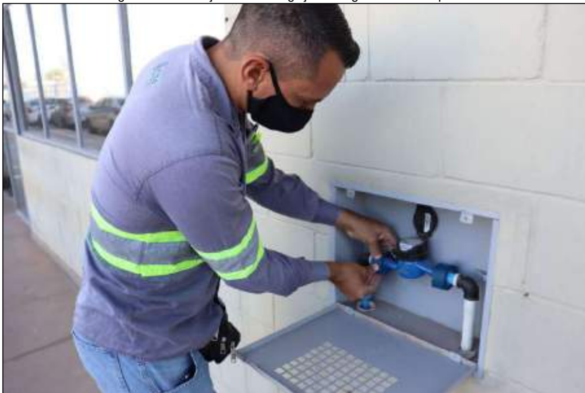
Figura 89 -Instalação de nova ligação de água com caixa padrão.
