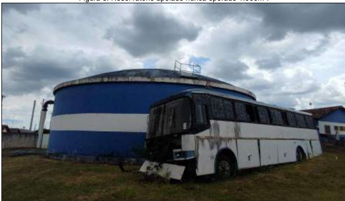
Figura 8: Reservatório apoiado nunca operado 1.000m 3 .
