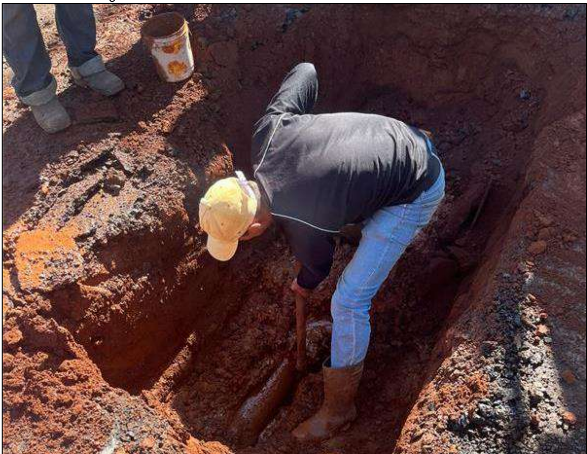
Figura 93: Conserto de rede de amianto em São José da Bela Vista.
