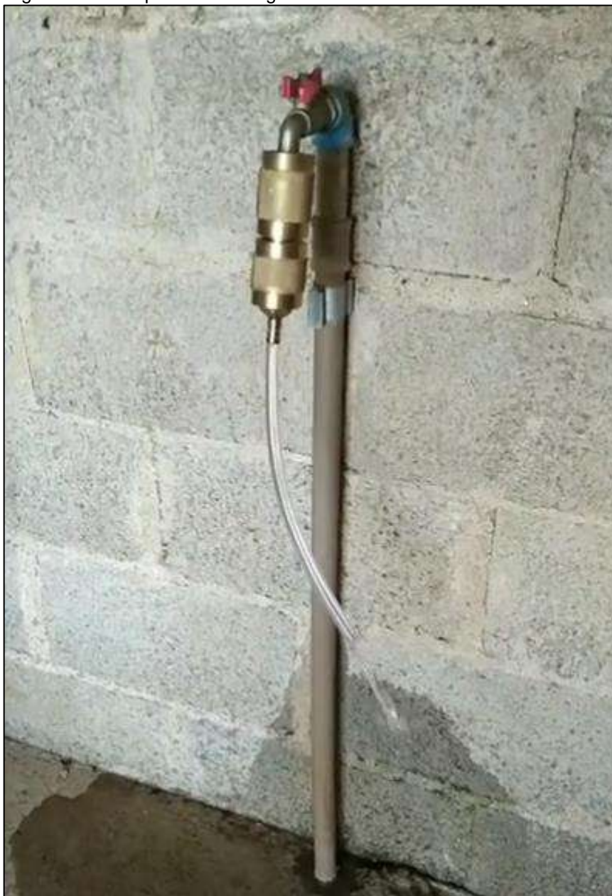
Figura 99: Exemplo de válvula geradora de onda em torneira residencial.
