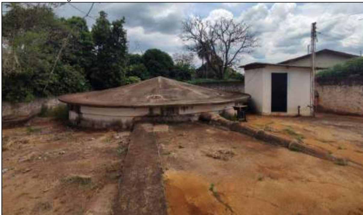
Figura 5: Reservatório enterrado 250m 3 e casa de bombas da EEAT.
