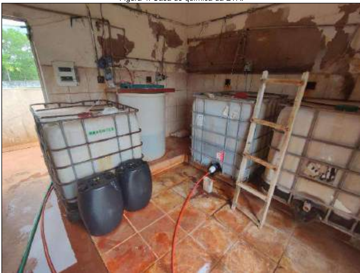
Figura 4: Casa de química da ETA.
