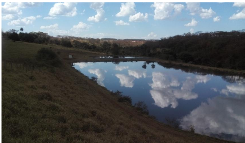
Foto 3.24 – Vista da lagoa facultativa
