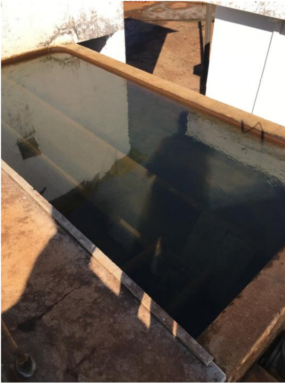
Foto 3.9 – Detalhe do filtro
