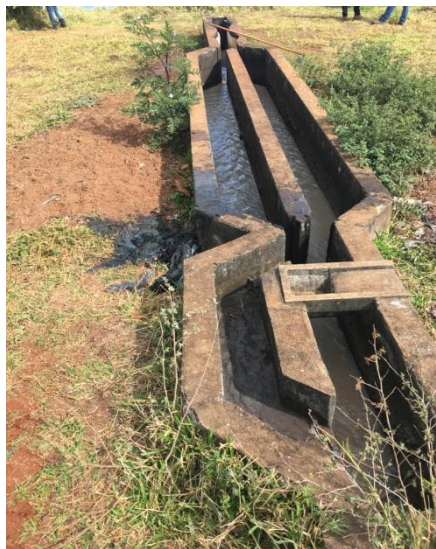
Foto 3.21 – Detalhe do tratamento preliminar
