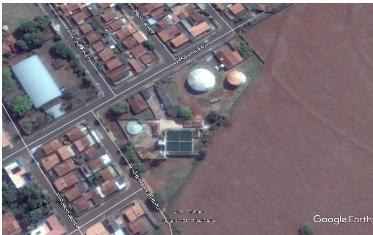
Foto 3.6 – Vista Aérea da ETA São José da Bela Vista e do Centro de Reservação
