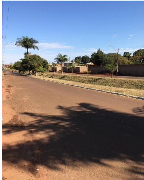
Foto 3.27 – Vista do trecho de sarjetas junto ao canal da Rua Luís Gonzaga Simei
