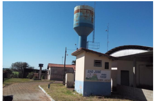
Foto 3.19 – Vista geral do reservatório elevado e do poço profundo de Buritizinho
