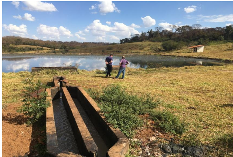
Foto 3.20 – Vista geral da ETE de São José da Bela Vista
