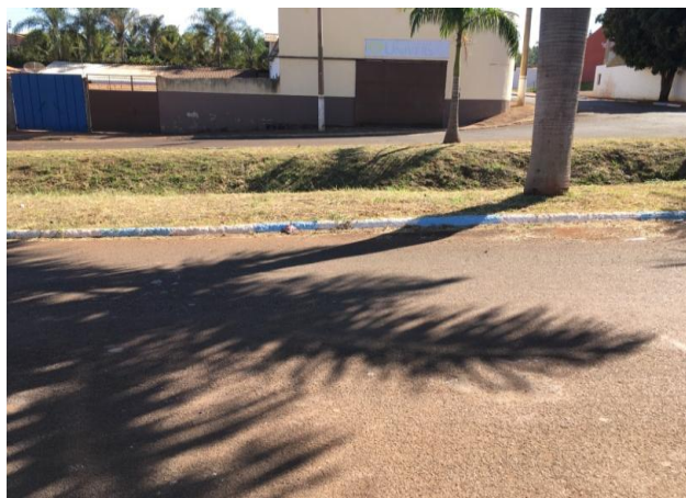
Foto 3.28 – Vista do trecho junto ao canal da Rua Luís Gonzaga Simei
