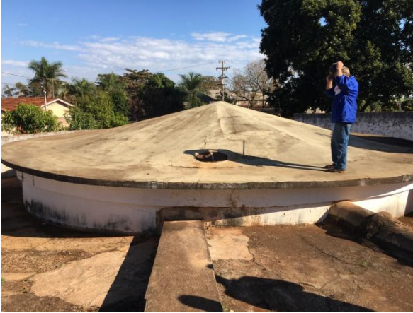
Foto 3.11 – Vista do reservatório enterrado
