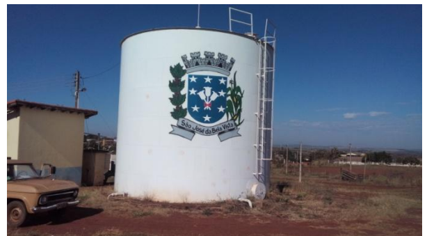
Foto 3.14 – Vista do reservatório apoiado metálico do Poliesportivo
