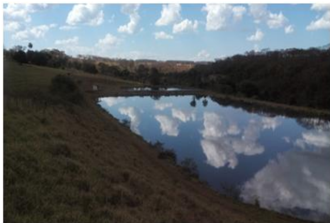
Vista da ETE de São José da Bela Vista
